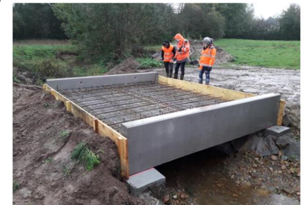
Illustration : remplacement d'un franchissement agricole impactant par une passerelle-cadre écologiquement transparente. Photo avant-après (photo : SCE)
