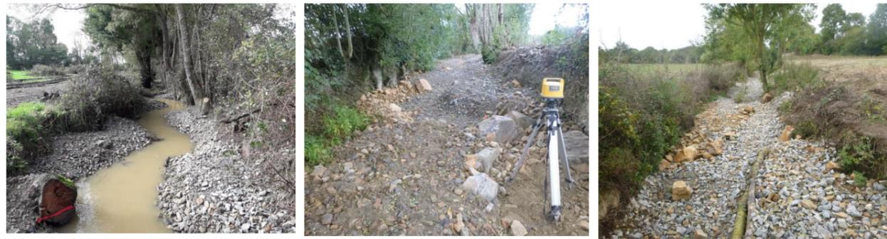
Illustration : Recharge granulométrique sur les affluents de l'Erdre (photos SCE)
