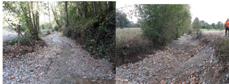
Illustration : Recharge granulométrique sur le cours d'eau de la Houssai l'Erdre (photos SCE)
